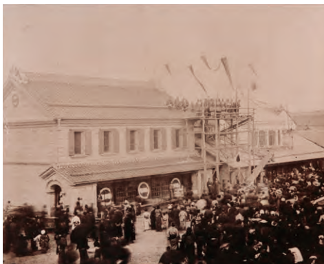
耐火性を備えた木骨石造の「丸一本間」呉服店舗。1902（明治35）年、増築部分の上棟式
