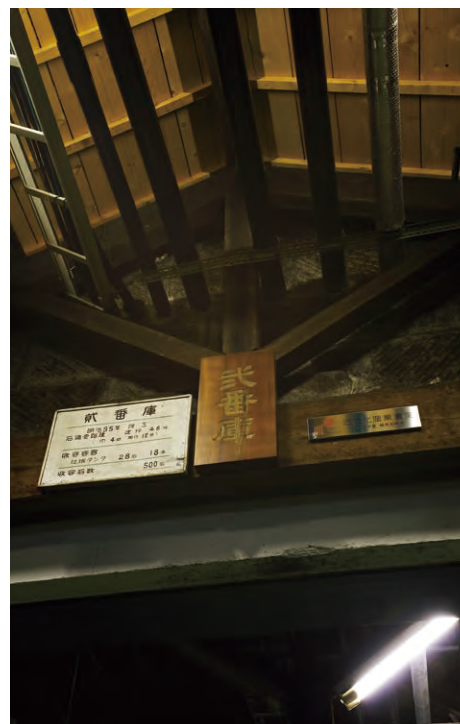
北の誉の式番庫に掛けられたプレート。「明治35年竣工」の文字がある
